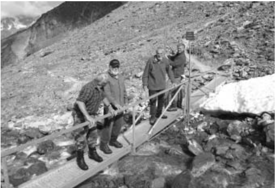
Bild 7. Die Brücke ist wieder begehbar
