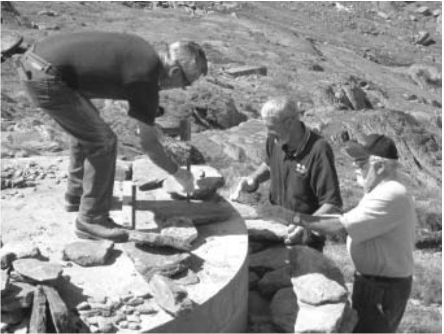
Bild 2. Der Abwasserschacht wird sorgfältig verkleidet.
