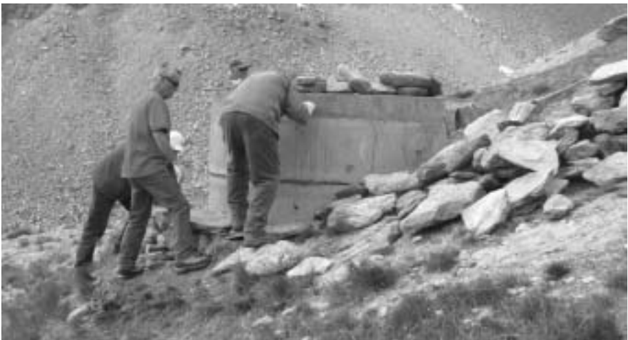
Bild 1. Abwasserschacht ("Spülkippe") am 28. Juni 2010
