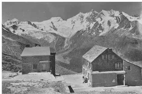
Abb. Links neue Hütte 1960, rechts alte Hütte saniert
