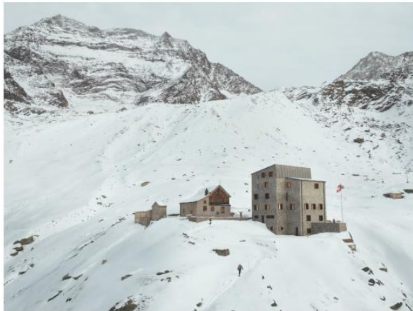
Weiterbauen – Die Haupttütte wird wie auch bereits im Jahr 1959 angedacht. Damit bleibt der Plancharakter und das Volumen kongruent und die Intervention angemessen.
